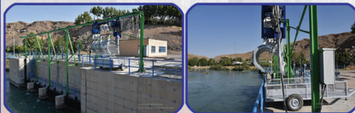
نصب آشفالگیر مکانیکی در آبگیر چم آسمان
