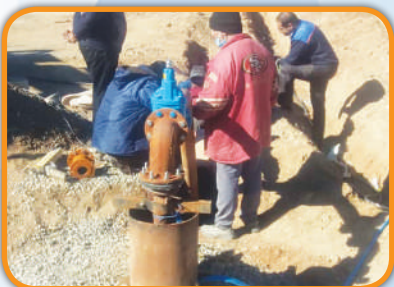
تجهیز چاه جدید روستای جهاد آباد
